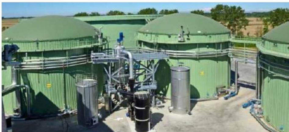
Slika 18 Spremnik za anaerobnu digestiju
