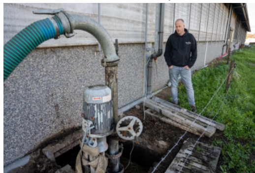
Vanuit de mestput wordt de mest elke twee uur naar de biovergister overgepompt
